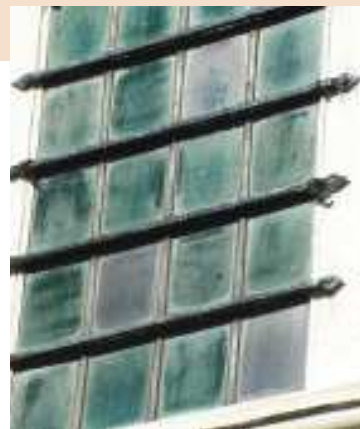
Glas-in-lood in een houten raam, met ter plaatse van elke horizontale loodlijn een windroede
