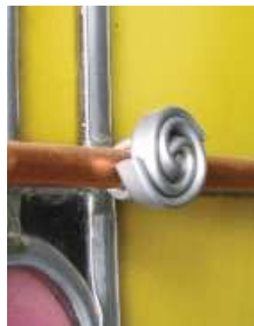
Bevestiging van een windroede aan een glas-in-loodpaneel met een zogenaamd roosje
