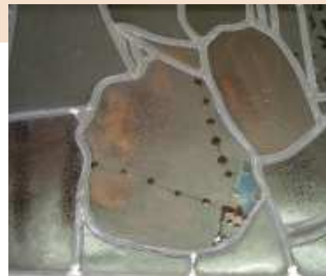
Partiële restauratie: het paneel is uitgenomen en in het atelier is alleen het gebroken glaasje verlijmd. De foto is genomen voordat de overtollige lijm verwijderd was
