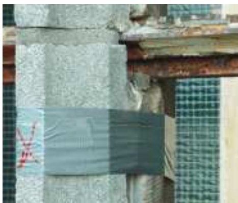
Detail van een glas-in-loodvenster. Het roestende, T-vormige brugijzer heeft de natuurstenen montant kapot gedrukt. Bij restauratie wordt het T-ijzer vaak vervangen door een beter afwaterende, rechthoekige brugstaaf met deklát
