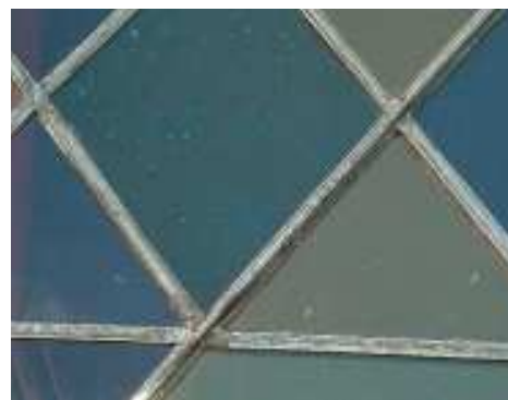
Detail van een raam zonder windroeden, maar waar een van de loodlijnen is versterkt. Deze loopt van middenonder schuin naar rechtsboven
