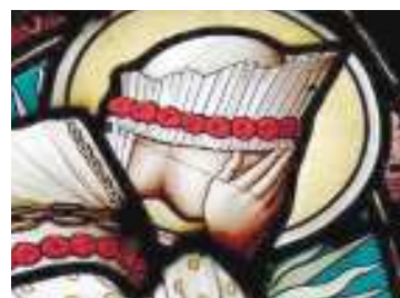
Detail van een gebrandschilderd raam met glasbreuk in het hoofd. Hier zijn breukloodjes ongewenst
